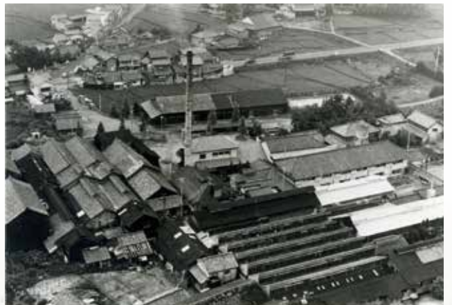
加茂蚕糸工場（北側上空から撮影）昭和38～39年頃 中央手前から、工場、汽缶場、事務所があり、煙突の向こうに正門があります。煙突の左には、倉庫、繭乾燥場、繭倉庫が続きます。写真には写っていませんが、さらに右に寮がありました。
