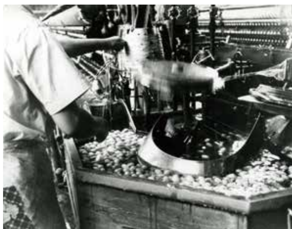
自動繰糸機の索緒作業 昭和45～46年頃 中央の機械の先にたくさんの索緒筭（実子筭）がついており、それが回転することで糸口を引き出しました。
